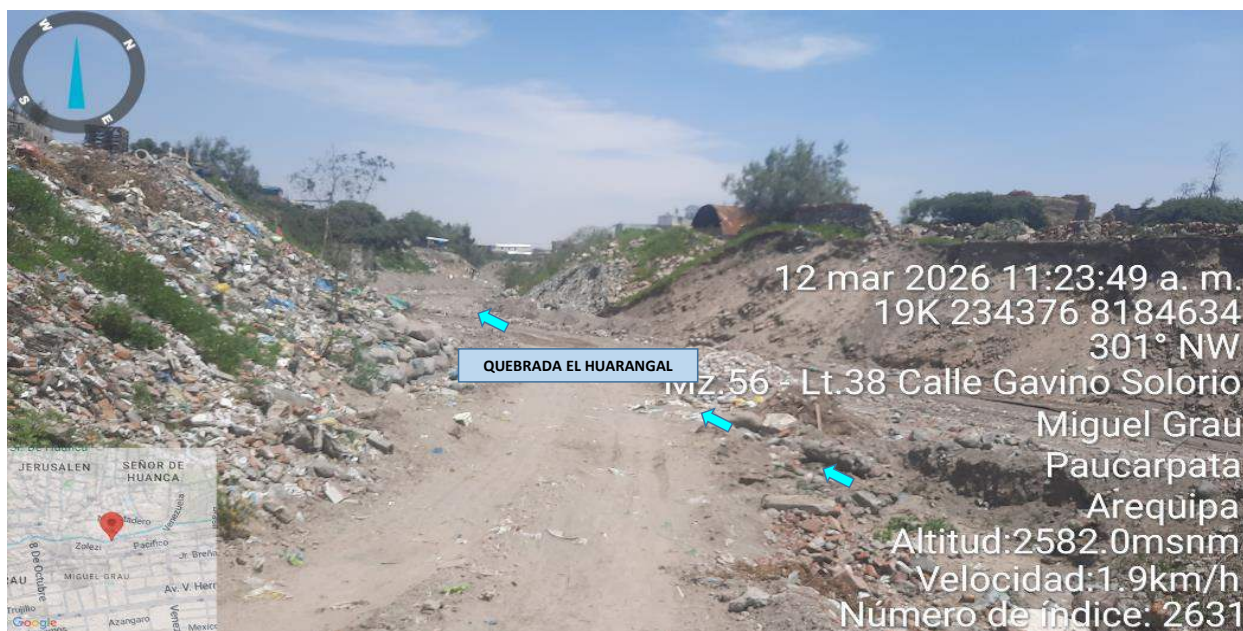
IMAGEN 02: EN ESTE TRAMO SE OBSERVA EN LA MARGEN IZQUIERDA DE LA QUEBRADA EL HUARANGAL, SU TALUD SE ENCUENTRA SIN PROTECCIÓN Y CON DESMONTE.
