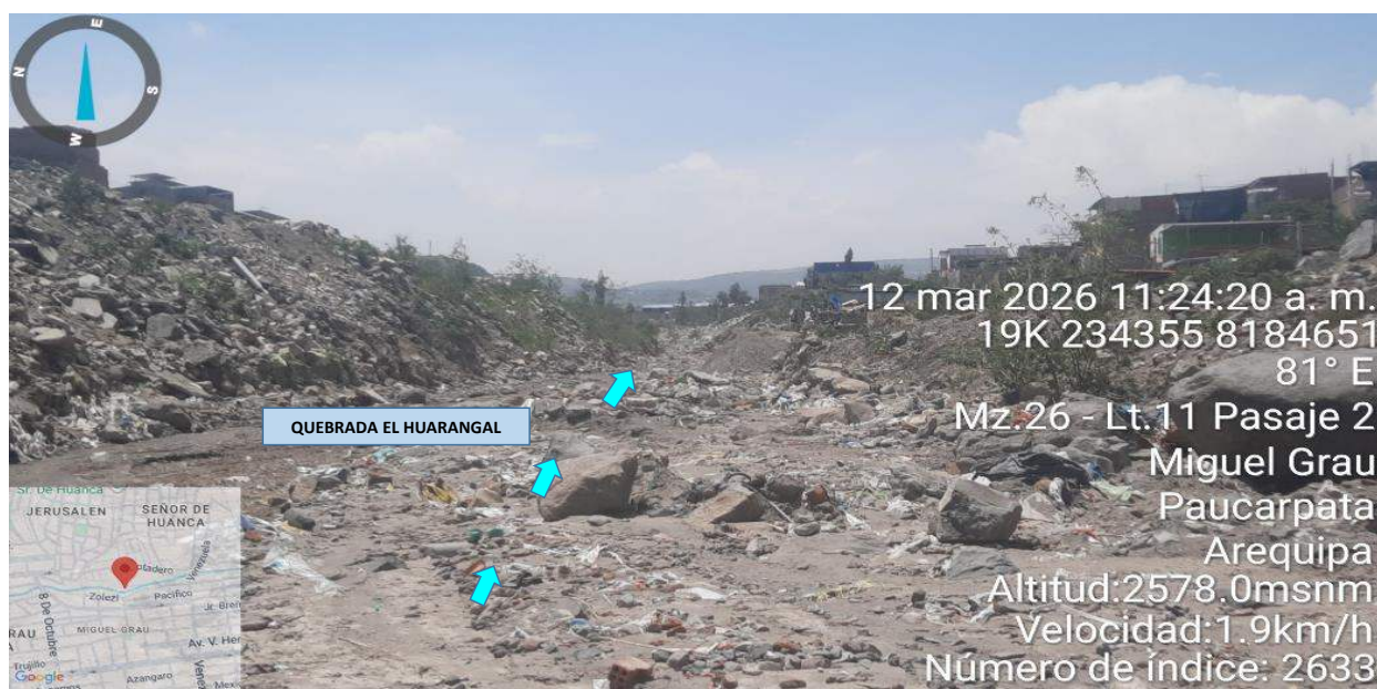
IMAGEN 03: EN ESTE TRAMO, SE OBSERVA EL TALUD EN MARGEN IZQUIERDA DE LA QUEBRADA EL HUARANGAL; SE ENCUENTRA DEBILITADO SIN PROTECCIÓN Y VIVIENDAS CERCANAS A DICHA MARGEN, Y SU CAUCE SE ENCUENTRA COLMATADO SEDIMENTOS Y PIEDRAS MEDIANAS.
